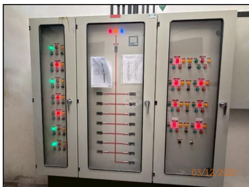
รูปที่ 2-17 ระบบมิเตอร์ไฟฟ้าสำหรับระบบบำบัดน้ำเสีย โดยเฉพาะ แยกจากระบบไฟฟ้าอื่น ๆ
