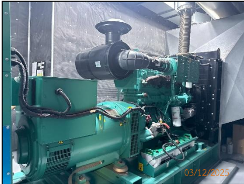
รูปที่ 2-49 เครื่องกำเนิดไฟฟ้า ขนาด 315 KVA จำนวน 1 ชุด สามารถสำรองไฟได้นาน 8 ชั่วโมง ในกรณีระบบไฟฟ้าขัดข้อง (2)
